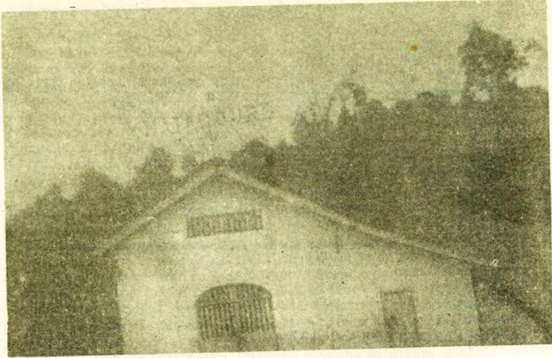
Antigo prédio do Matadouro Municipal, no mesmo local em que funcionou a Usina Elétrica Municipal, conhecida por "Usininha". O matadouro atual ali mesmo se situa.
