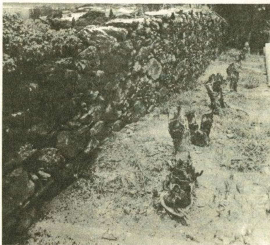
Muro de pedra do cemitério local. Mais de lo que centenário. Tem resistido à mania de remodelação.
