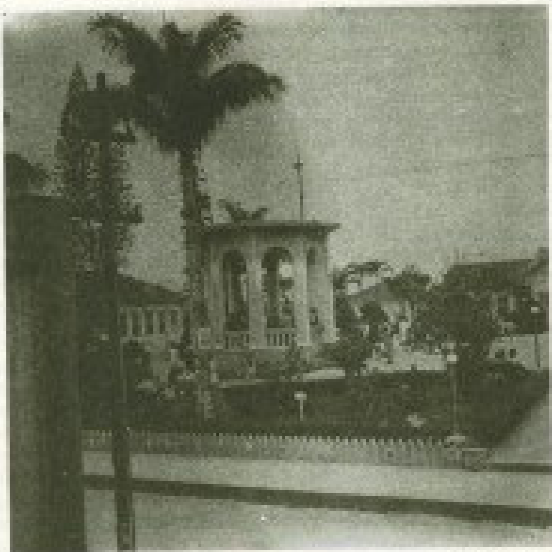
O alvaré como construído na cidade, no Largo da Matriz. Projeto do engenheiro Antônio Mascari Filho.
